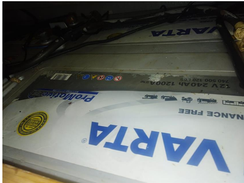
Imagen 17. Baterías de la embarcación bajo estudio.
