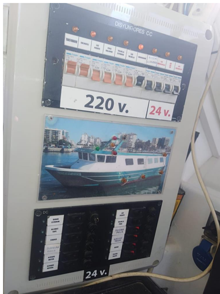
Imagen 20. Cuadro eléctrico general del barco de estudio.
